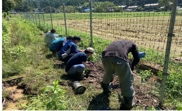
写真2 獣害用防護柵修理②
