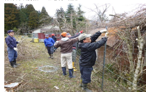
獣害防護柵の点検、補修
