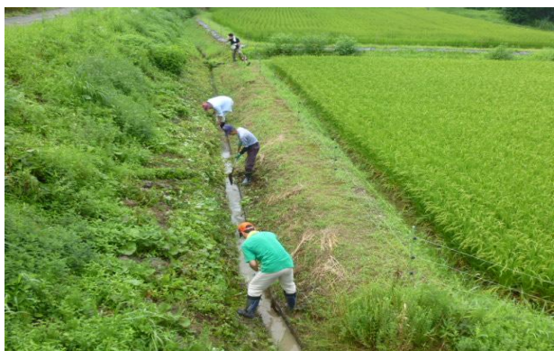
排水路の泥上げ
