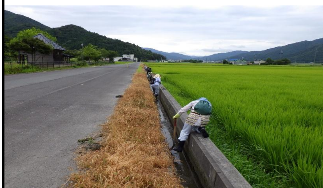
写真1 水路の泥上げ作業
