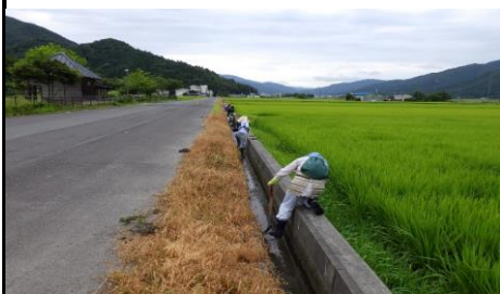
写真1 水路の泥上げ作業
