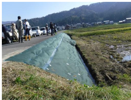
写真2 防草シート張り
