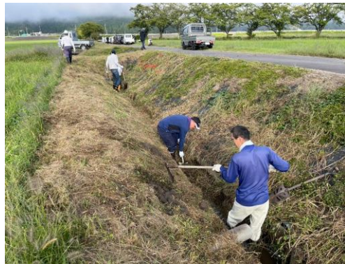
写真1 排水路の泥上げ
